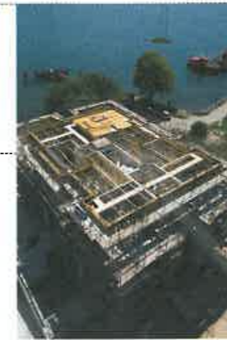
Schneller Baufortschritt durch das Bausystem
