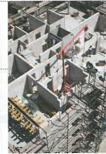
Die Wohnungstrennwände wurden aus Schallschutzgründen in d=30 cm ausgeführt
